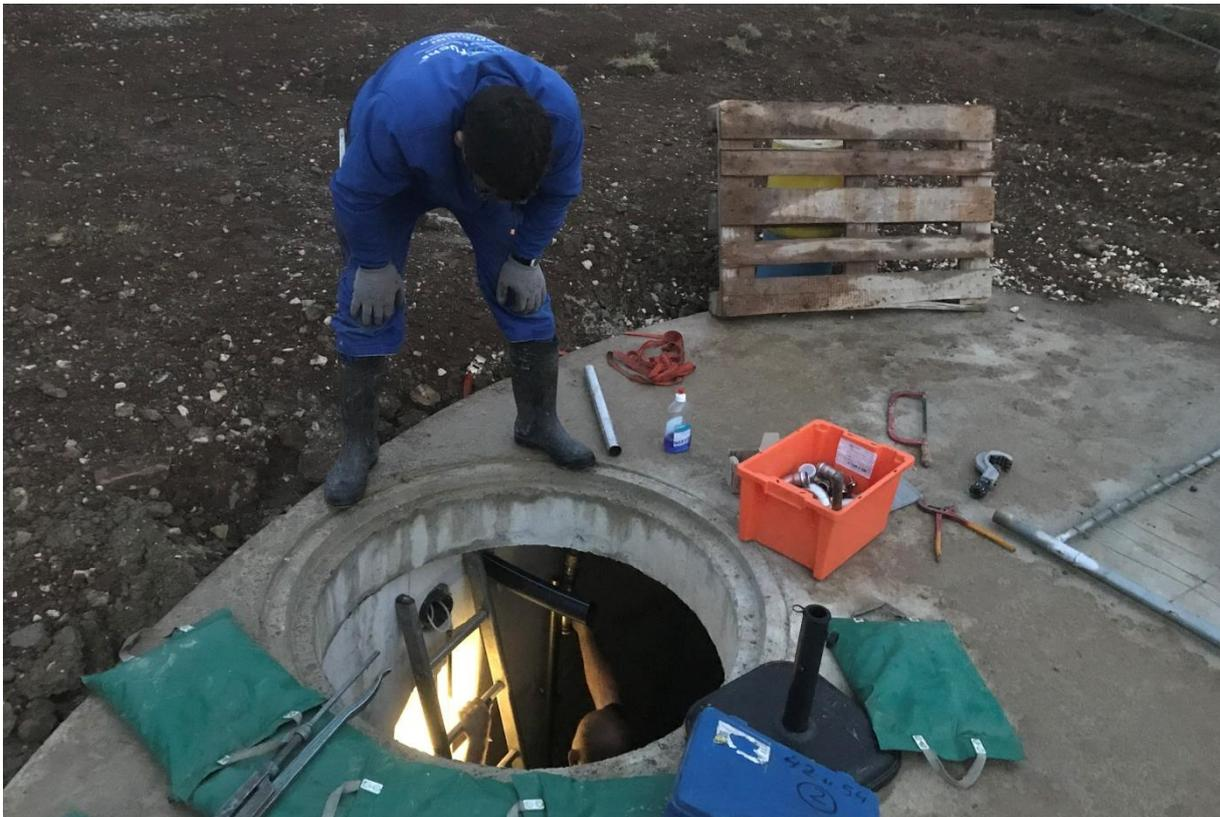
Weiterhin wurde zugleich an den Einläufen des Brunnenwassers sowie der Notspeisung mit „Gemeindewasser“ die notwendige Verrohrung für den sanften Wassereinlauf vorgenommen. Zudem wurde ein Rohr in der Zisterne angebracht um dort später die notwendige Verkabelung der Schwimmersensoren, die das Ein- und Ausschalten der Brunnenpumpe steuern werden, anbringen zu können.
